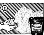
Без да чакате, нанесете КЬОСТЕР KD 3 Течна изолация с КЬОСТЕР Четка за течности.
